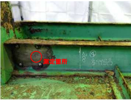
図-5 ボルト周辺部の施工前後の状況及び分析の結果
