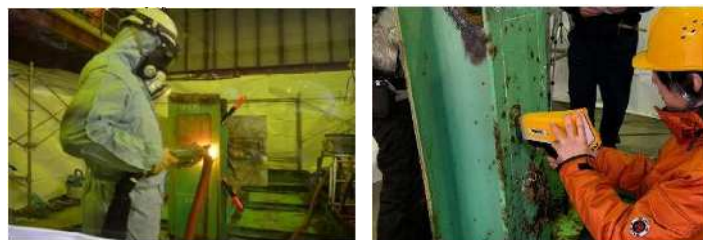
(a)塗膜除去状況 (b)各元素の測定状況
