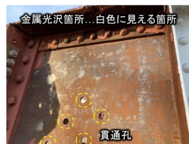
図2 素地調整後の外観
