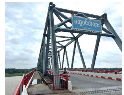
図-2 試験施工対象のMaubin橋
