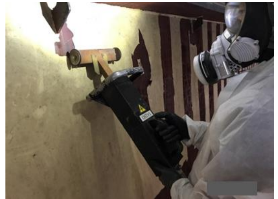
写真-2 IH 工法による剥離状況
