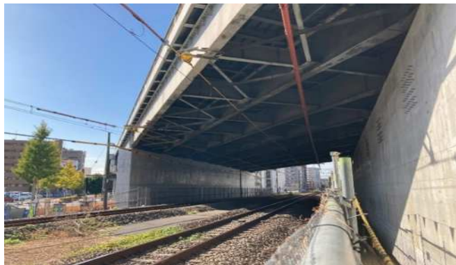
写真-1 施工前全景
