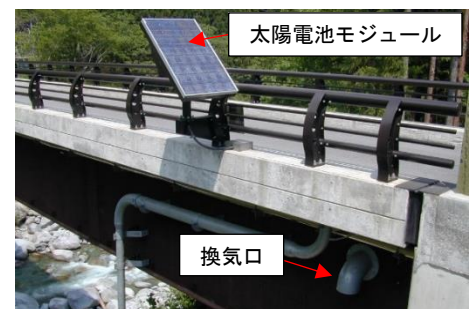
写真-1 換気システム設置状況（外側）
