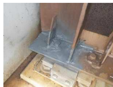
(b) 点検時の応急補修
