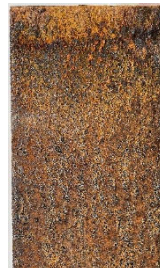
鋼板の表面状況
